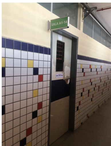
FIGURA 21- Porta da da sala A1-14 Fonte: autor
