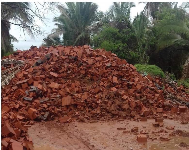
Figura 12 – Resíduos de blocos e telhas cerâmicos
