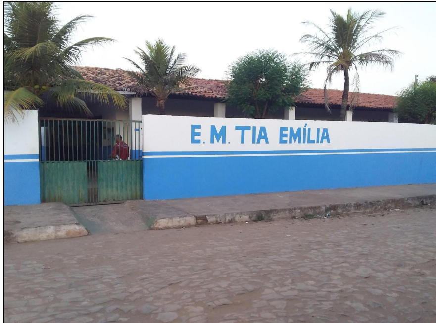
Fotografia 11 - Fachada da Escola Municipal Tia Emília
