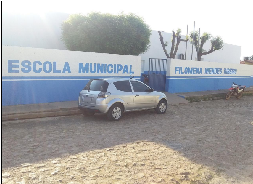
Fotografia 01 - Fachada da Escola Municipal Filomena Mendes Ribeiro
