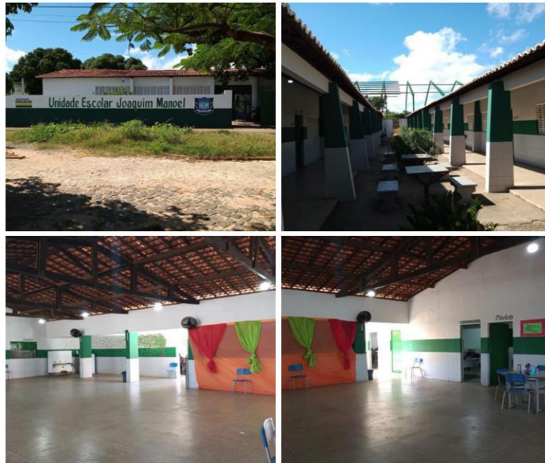
Figura 2: Unidade Escolar Joaquim Manoel, localizada em Valença do Piauí - PI
