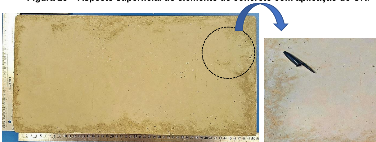
Figura 25 – Aspecto superficial do elemento de concreto com aplicação do OR.
