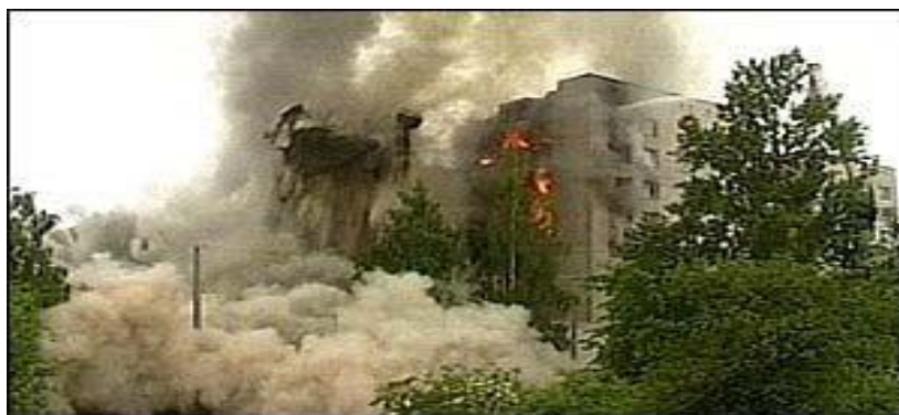
Figura 11 – Colapso total de um edifício residencial em São Petersburgo – Rússia, 2002
