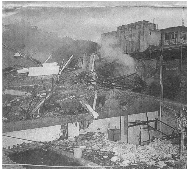
Figura 17 – Danos estruturais do Edifício Cacique, em Brasil, 1996
