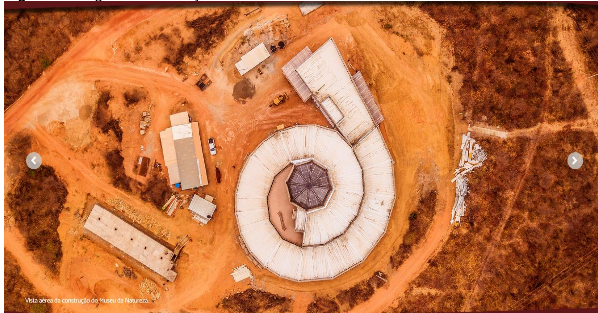
Figura 1. Imagem da construção do Museu da Natureza.
