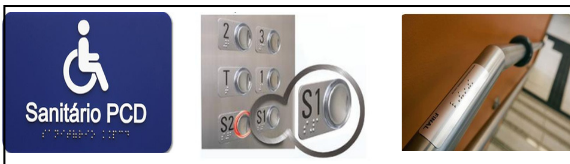
Figura 28 – Sinalização em Braille: placa em sanitário para PcD, botões em elevador e adesivo em corrimão de escada
