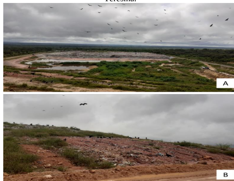
Figura 3 – Resíduos expostos (A) e Urubus e formação de lamas (B) no Aterro Sanitário Municipal de Teresina.
