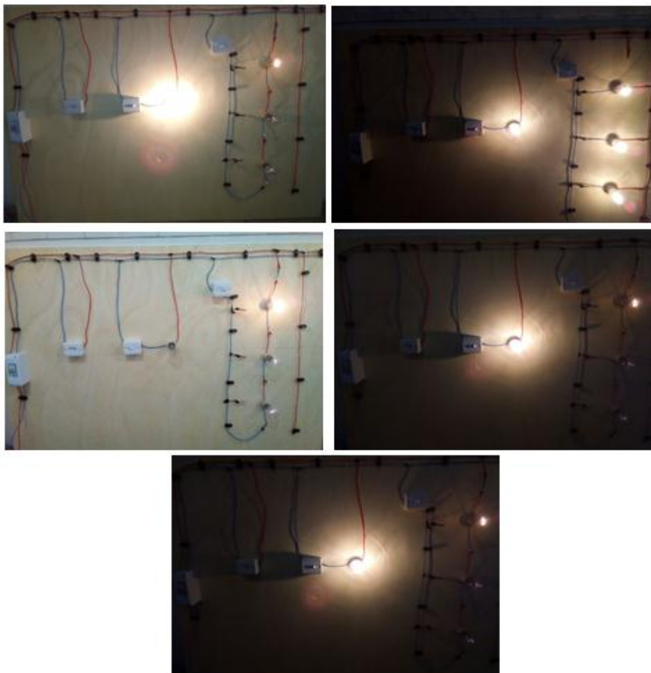
Figura – 8 maquete elétrica de execução prática em funcionamento ligada a uma rede elétrica de 220 v.
