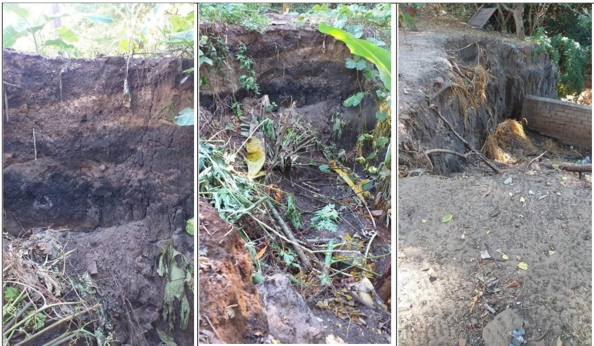
Figura 2. Neossolo Quartzarênico e construção de muro de concreto com o intuito de amenizar a erosão local.
