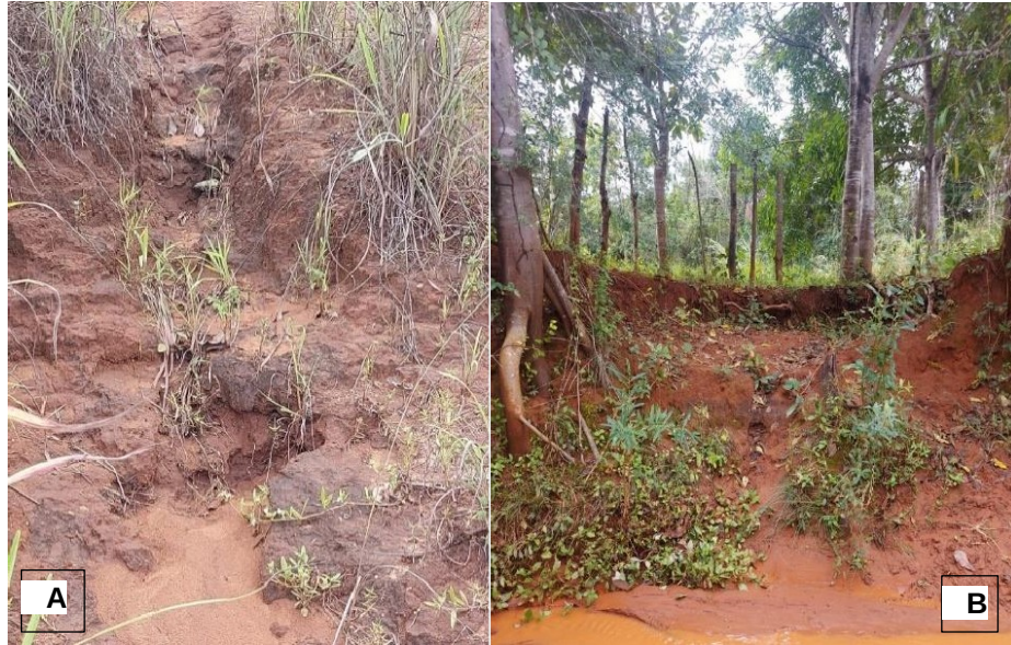
Figura 5 - Erosão nas Margens do Riacho
