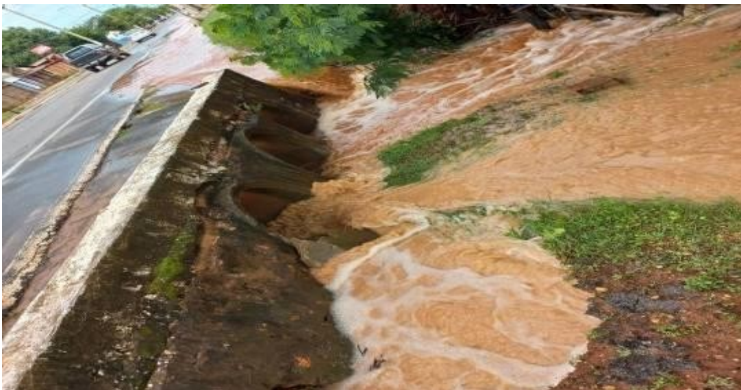
Figura 08 - Boca - de- Lobo em dia de chuva de baixa intensidade exercendo seu papel.
