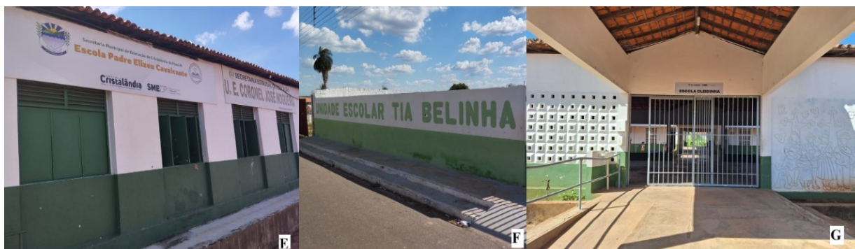
Figura 3 - Fachada das Escolas localizadas na zona urbana do município de Cristalândia do
