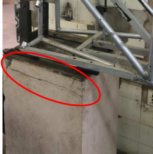
Figura 65. Suporte danificado.
