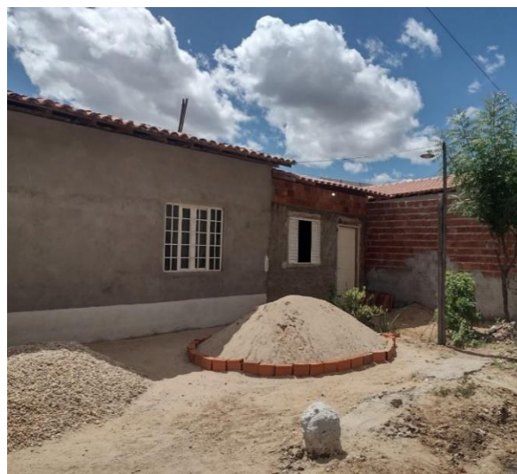
Figura 12 - Fachada frontal revestida de cimento.
