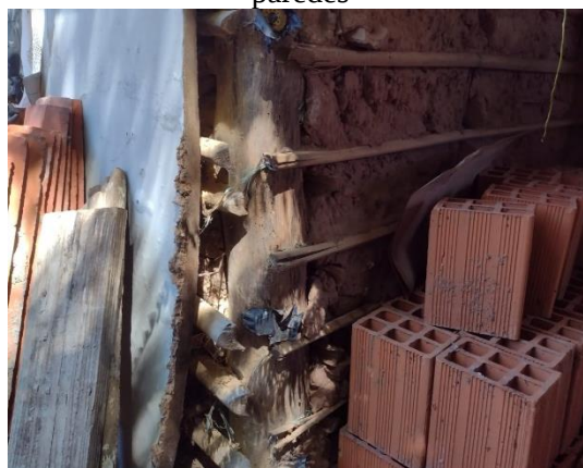
Figura 15 – Estrutura de bambu e barro das paredes
