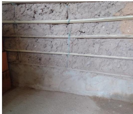
Figura 8 – Revestimento de cimento na parte inferior de parede de barro como proteção contra alagamentos.
