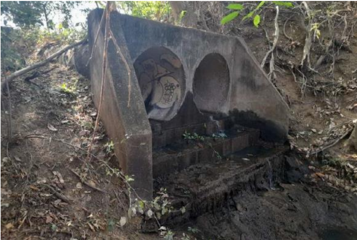
Figura 30 - Dispositivo de extravasão do reservatório
