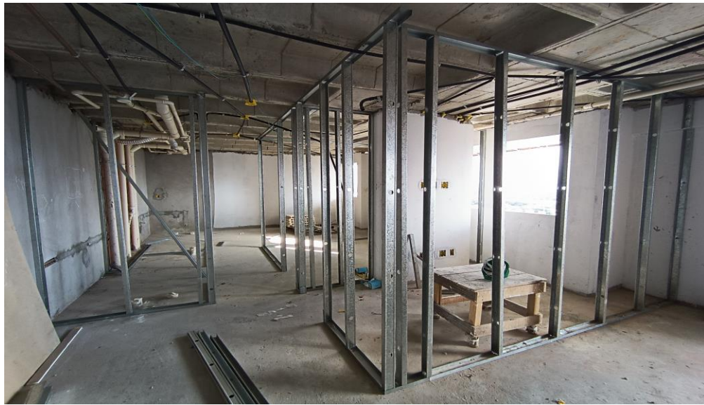
Figura 05 - Fixação dos montantes
