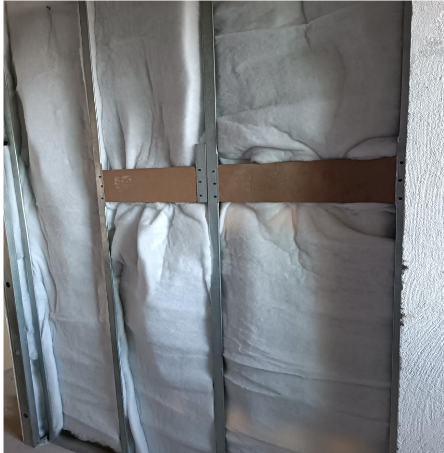
Figura 06 - Fixação dos reforços para fixação de cargas pré-definidas
