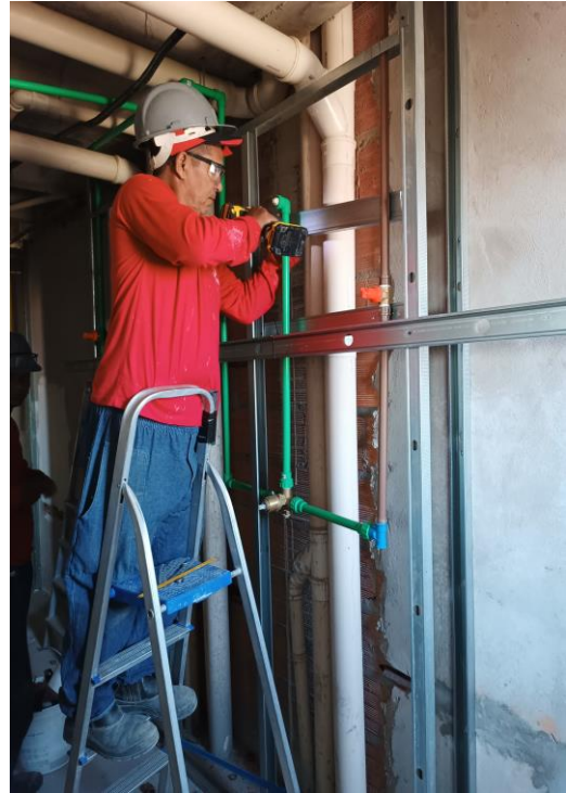
Figura 10 - Locação e fixação das instalações
