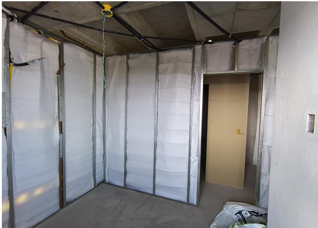
Figura 11 - Instalação do isolante acústico
