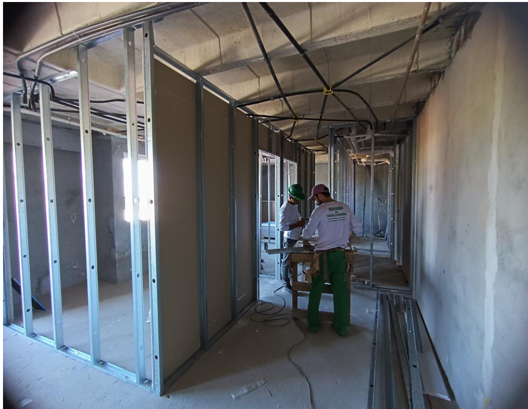
Figura 07 Instalação da primeira face da parede
