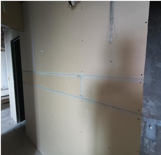
Figura 14 - Acabamento em drywall
