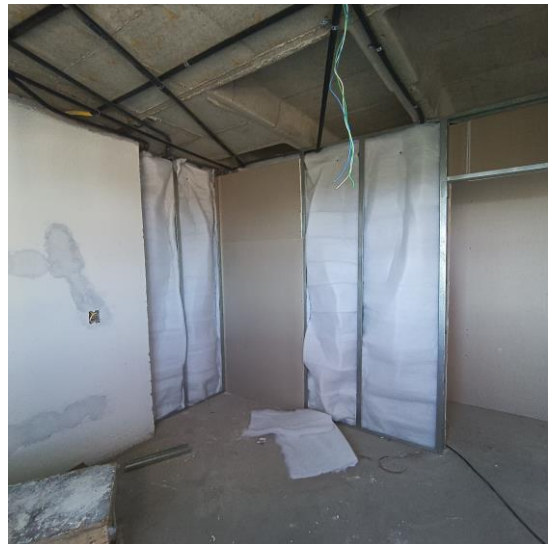
Figura 13 - Execução da segunda face da divisória
