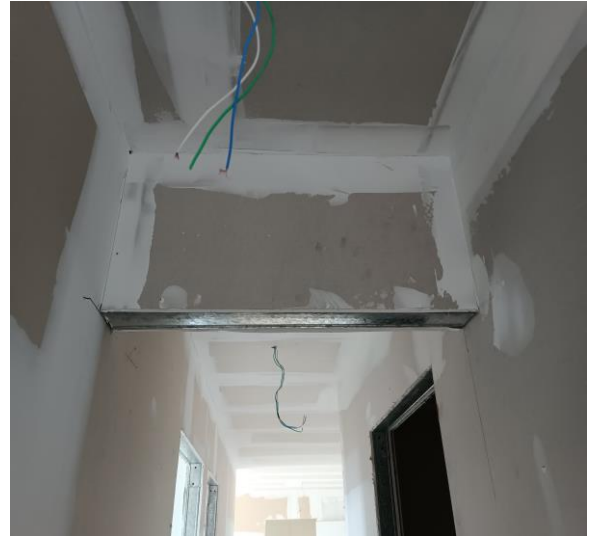
Figura 15 - Acabamento em drywall
