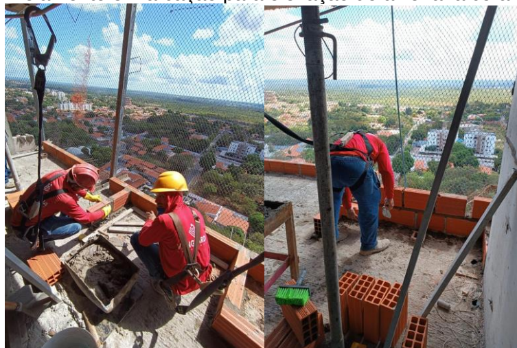
Figura 13 - Nivelamento e marcação para elevação de alvenaria cerâmica – Obra A
