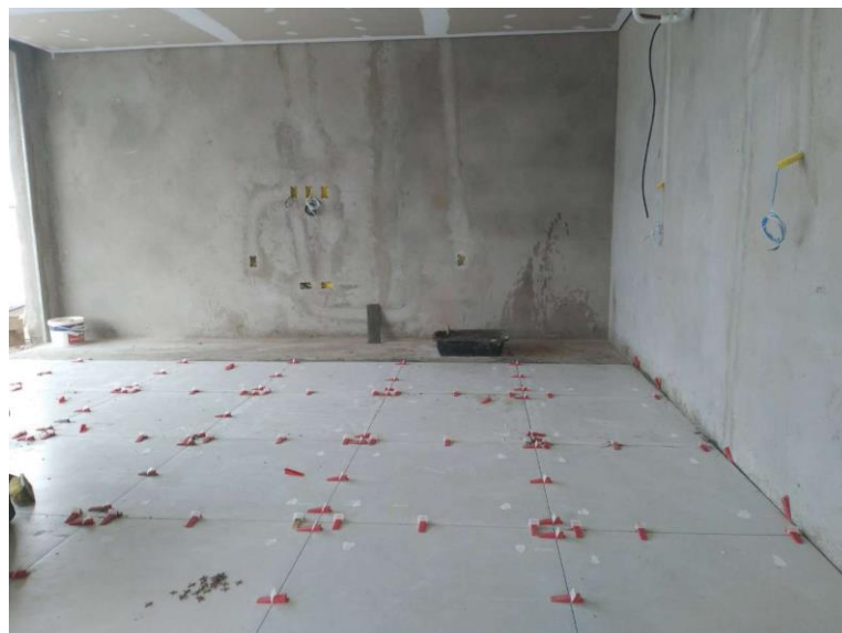
Figura 19 - Aplicação de revestimento cerâmico em pisos – Obra B
