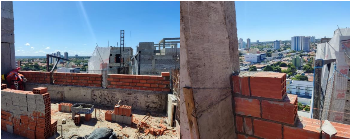
Figura 17 - Nivelamento e elevação de alvenaria cerâmica em área externa – Obra B
