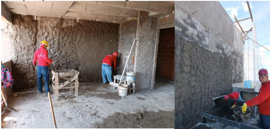
Figura 14 - Aplicação do reboco com argamassa em área interna e externa – Obra A
