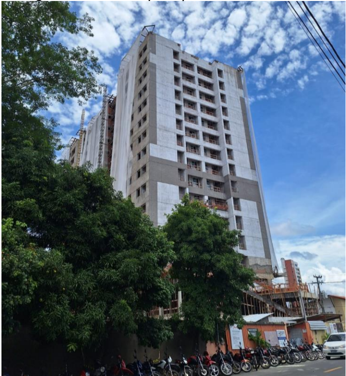
Figura 5 - Fachada principal do edifício – Obra A
