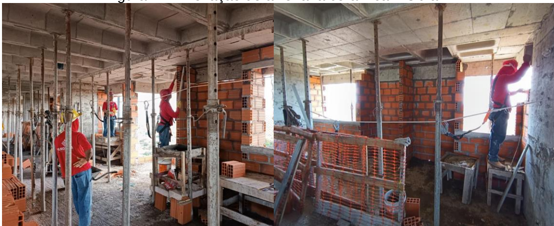
Figura 12 - Elevação de alvenaria cerâmica – Obra A
