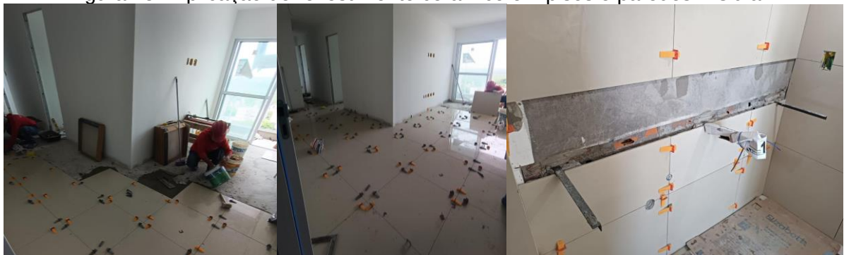
Figura 15 - Aplicação de revestimento cerâmico em pisos e paredes – Obra A
