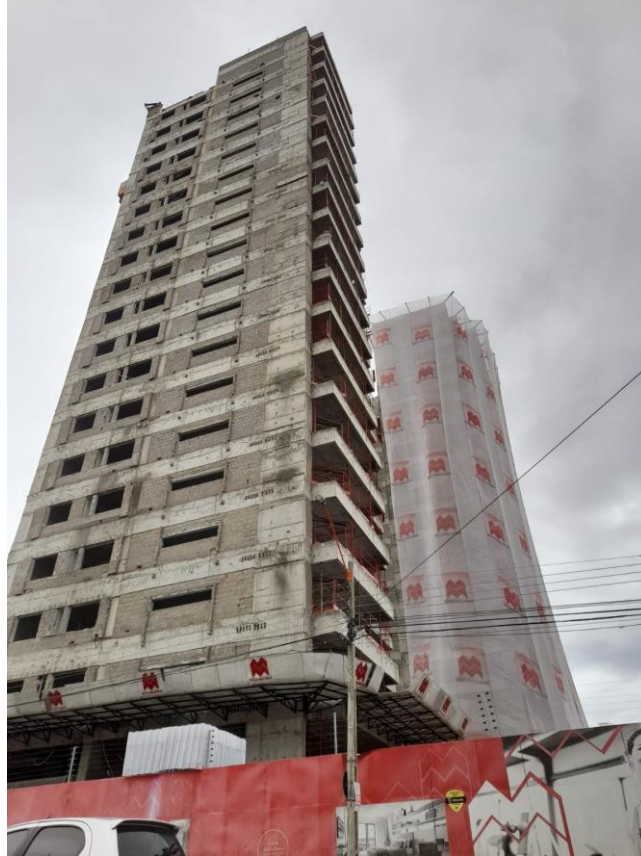
Figura 8 - Fachada do edifício - Obra B
