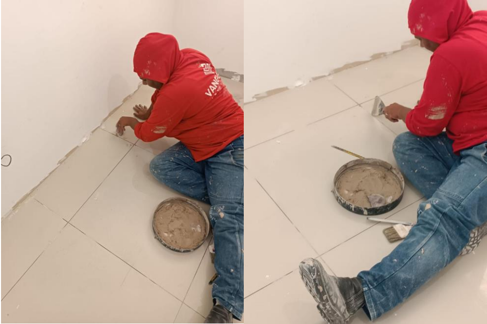
Figura 16 - Aplicação de rejunte – Obra A
