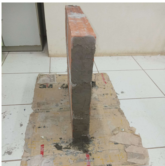
Figura 8 - Vedação das aberturas dos blocos cerâmicos.
