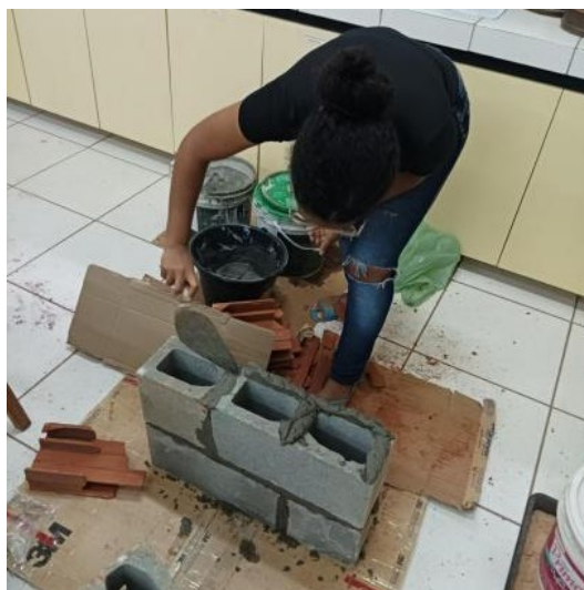
Figura 6 - Construção do protótipo com bloco de concreto.
