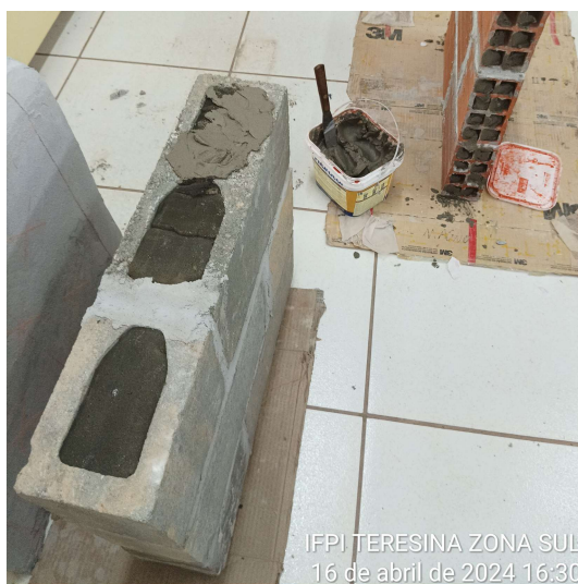
Figura 7 - Vedação das aberturas dos blocos de concreto.
