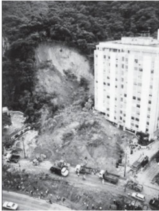
Figura 2 - Escorregamento do morro dos cabritos, Rio de Janeiro 1998.
