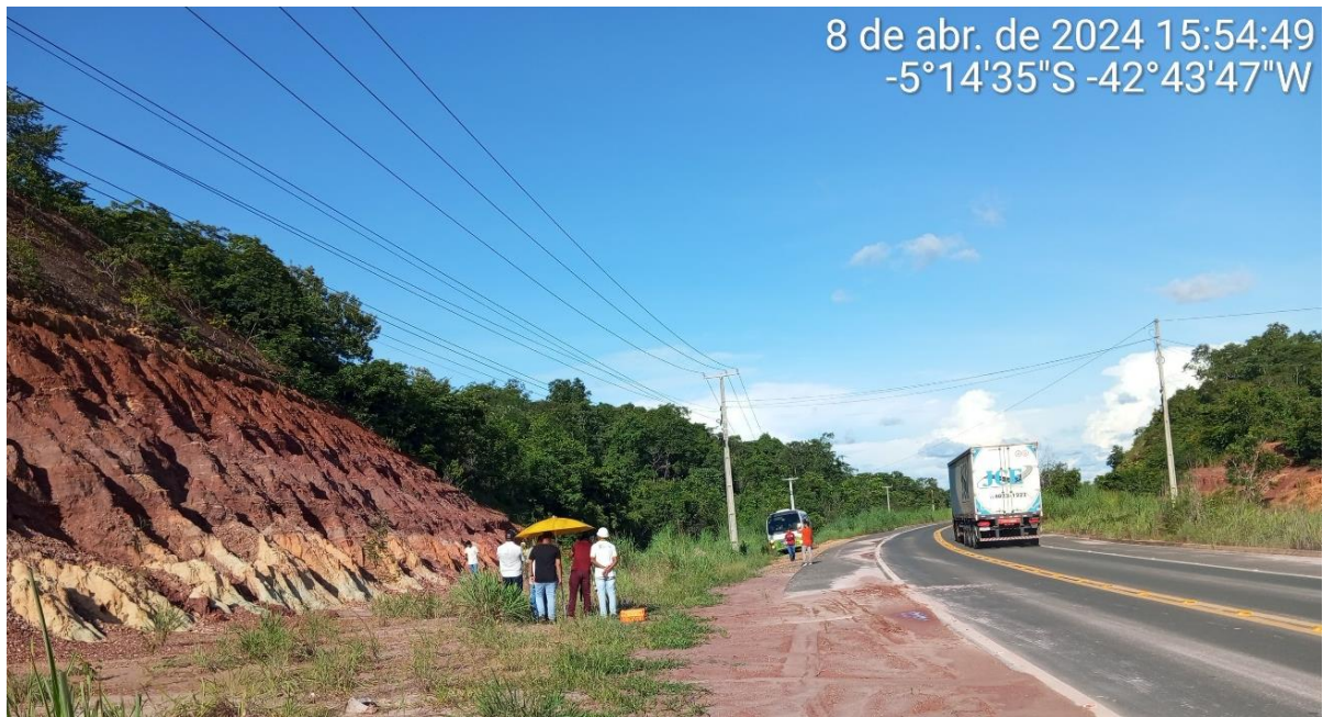
Figura 1 – Registro de um talude rodoviário.
