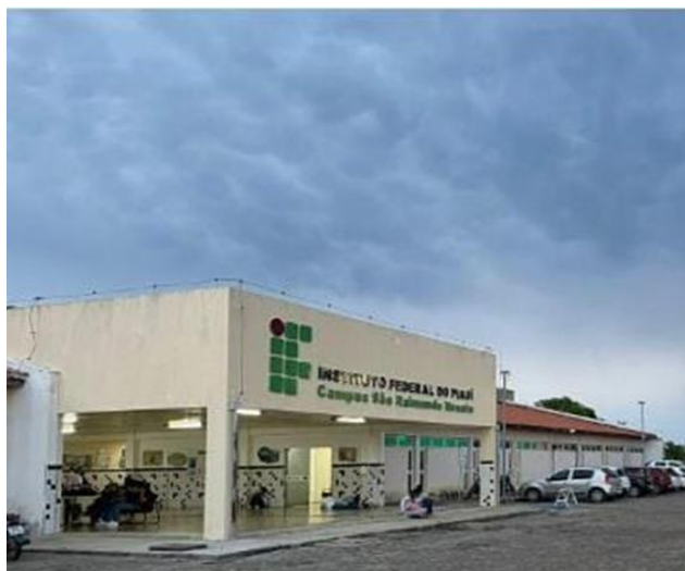
Figura 4: Fachada do Instituto Federal de Ciência e tecnologia do Piauí- São Raimundo Nonato
