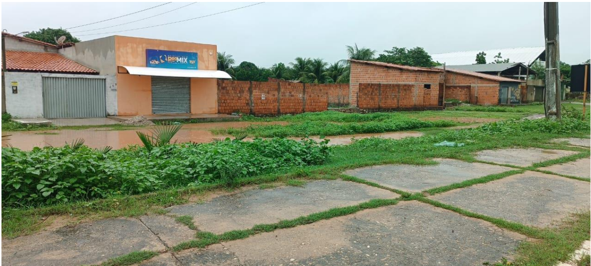
Figura 38 – Ponto de alagamento no Setor 1 (Avenida Parnaíba)
