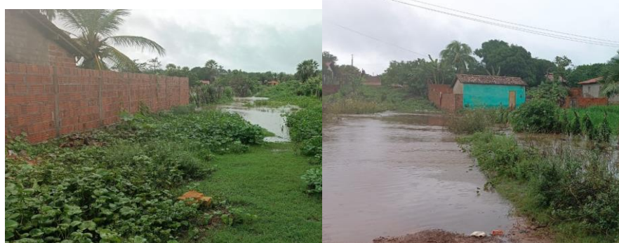
Figura 37 - Ponto de alagamento nos setores 6 e 7 (Bairro Vila Nova)
