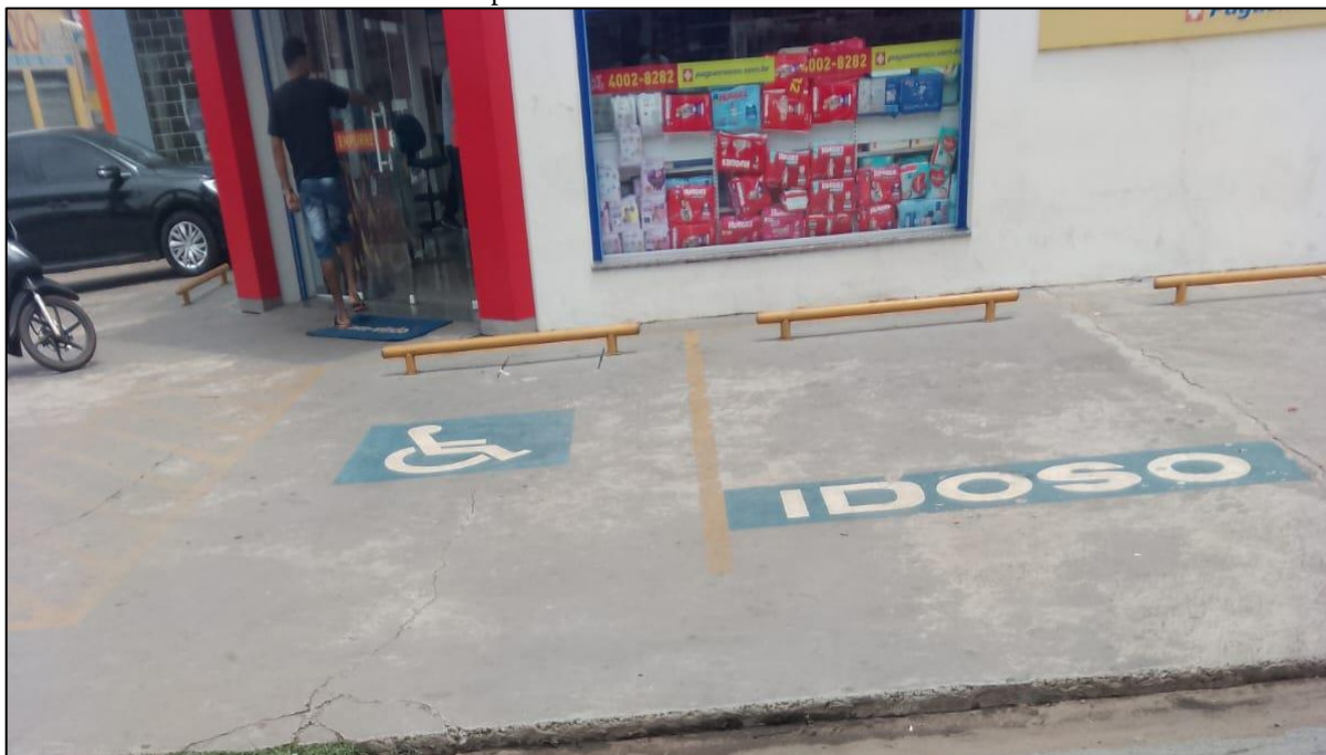
Figura 11 - Ilustração da ausência da sinalização adequada nas vagas de estacionamento designadas a pessoa com deficiência e a pessoa idosa na Rua Afonso Pena.
