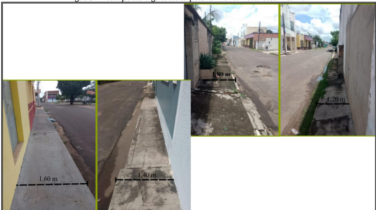
Figura 31 - Ilustração das larguras das calçadas na Avenida Doutor José Anselmo.
