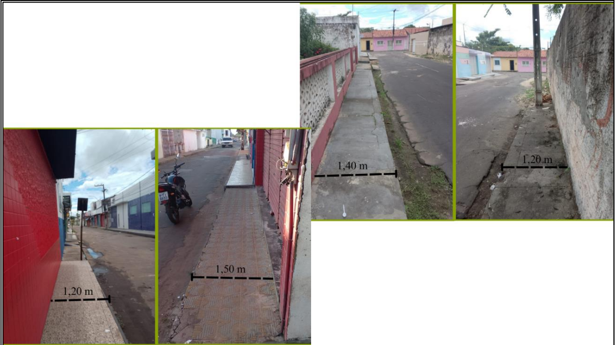
Figura 24 - Ilustração das larguras das calçadas na Rua Fernando de Carvalho.
