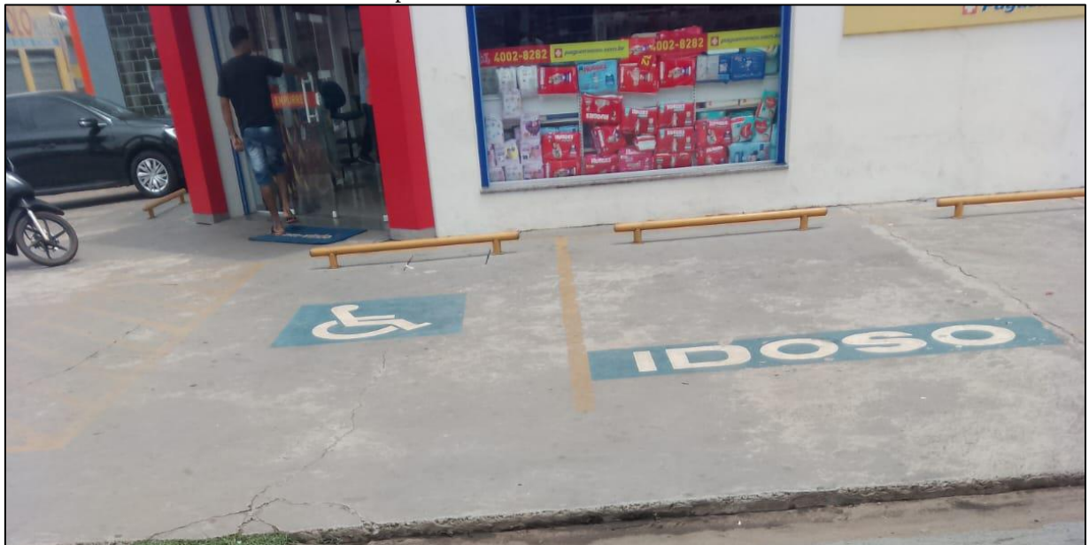
Figura 22 - Ilustração da ausência da sinalização adequada nas vagas de estacionamento designadas a pessoa com deficiência e a pessoa idosa na Rua Afonso Pena.
