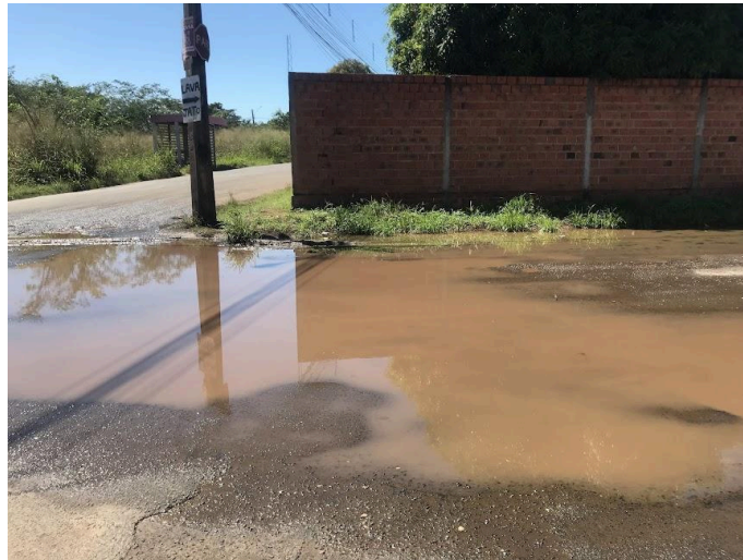
Figura 19: Ruas do bairro Vale do Gavião com esgoto acumulado.
