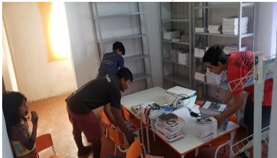
Figura 3 - Construção da biblioteca Ramkokamekrá Canela na Aldeia Indígena Escalvado, Fernando Falcão - MA, 2022.
