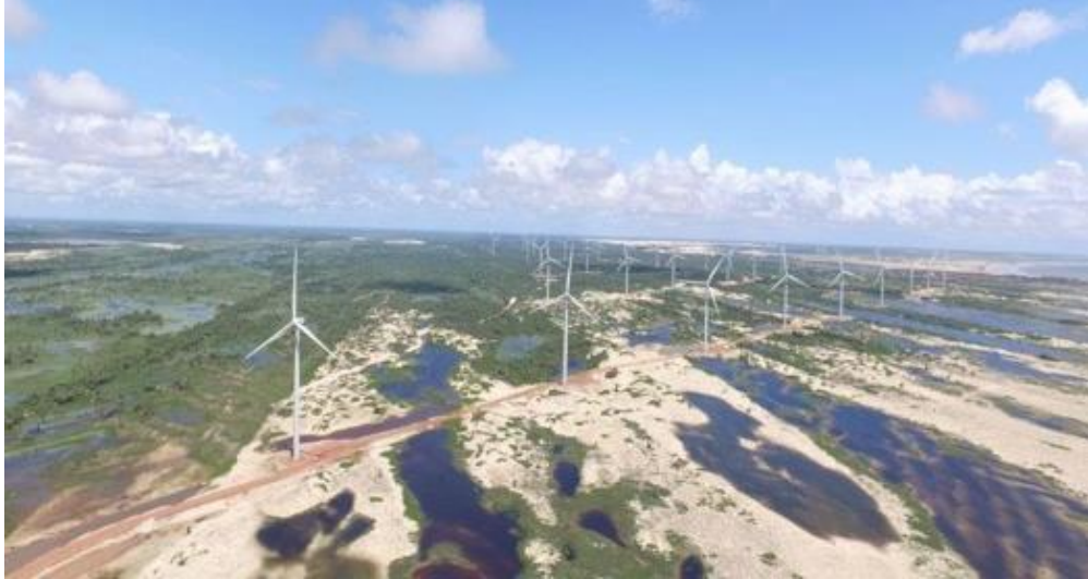
Foto 4 - Fotografia das turbinas eólicas instaladas em meio as lagoas e dunas:
