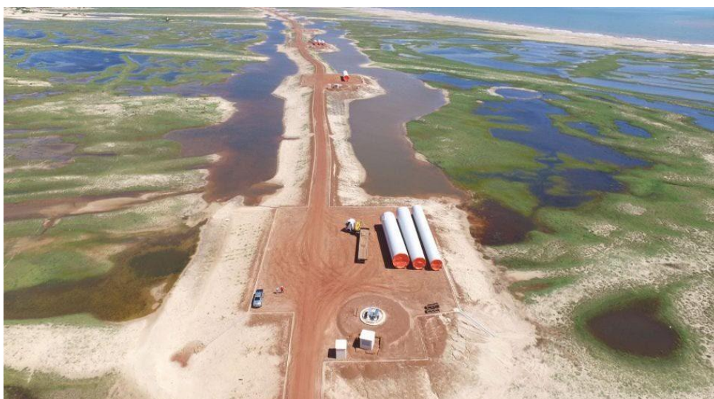
Foto 2 - Fotografia enfatizando o processo de terraplanagem, juntamente com a compactação do solo para a instalação das turbinas no Delta:
