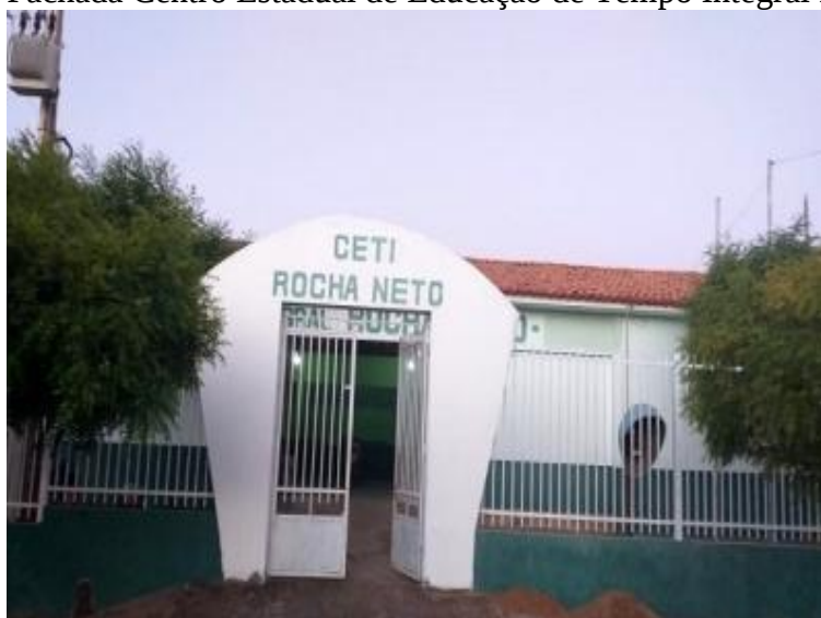
Figura 8 – Fachada Centro Estadual de Educação de Tempo Integral Rocha Neto
