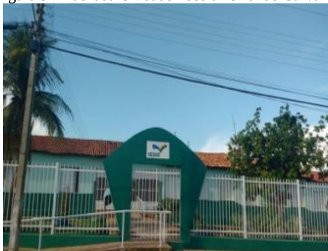
Figura 3 – Fachada Unidade Escolar Orlando Carvalho
