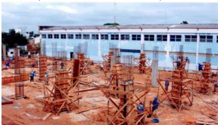
Figura 8 – Construção do Edifício B do CEFET/PI, atual Campus Teresina-Central em 2000.
