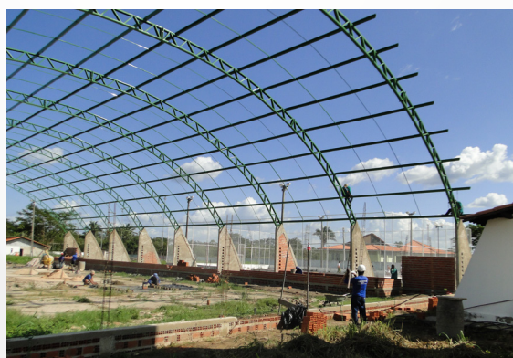
Figura 17 – Construção do Ginásio Poliesportivo (2012)
