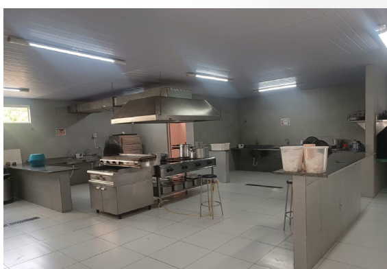
Figura 20 – Reforma da Cozinha do Refeitório Institucional (2023)
