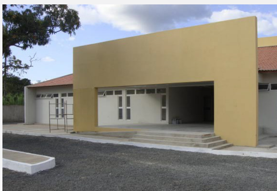
Figura 7 – Fachada do Campus (2009)
