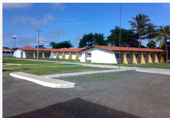
Figura 8 – Área externa do prédio dos laboratórios (2009)
