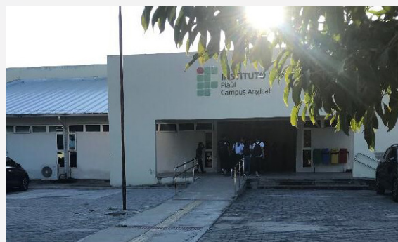
Figura 56 – Fachada do Campus
