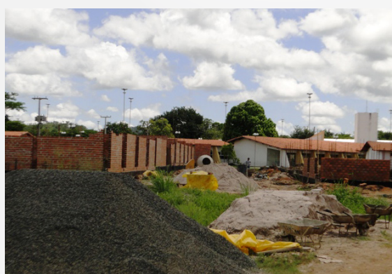
Figura 19 – Construção de mais 10 (dez) salas de aula (2014)
