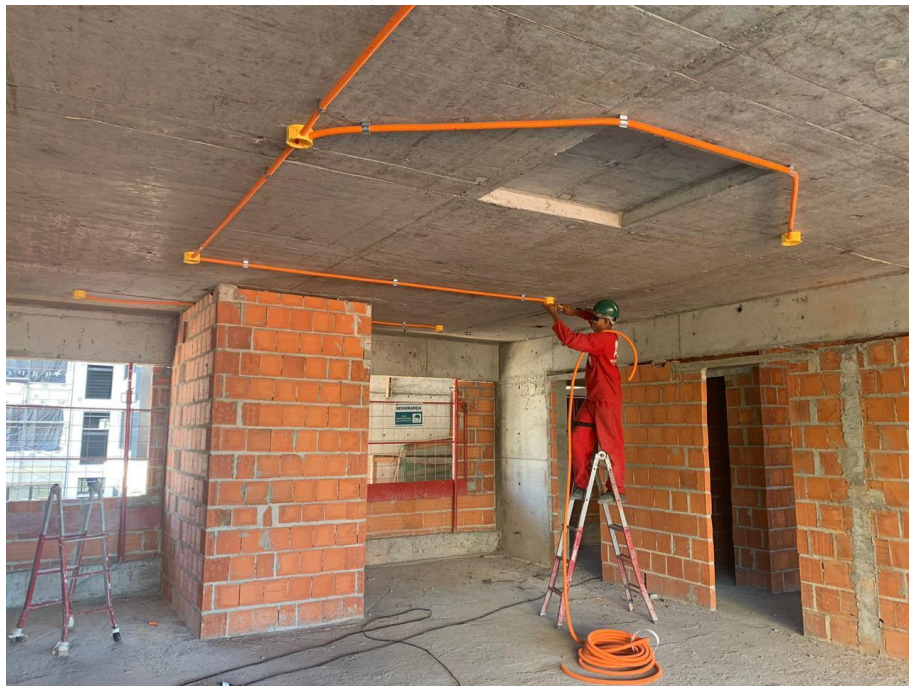
Figura 18 - Execução instalações elétricas condomínio The Pallace
