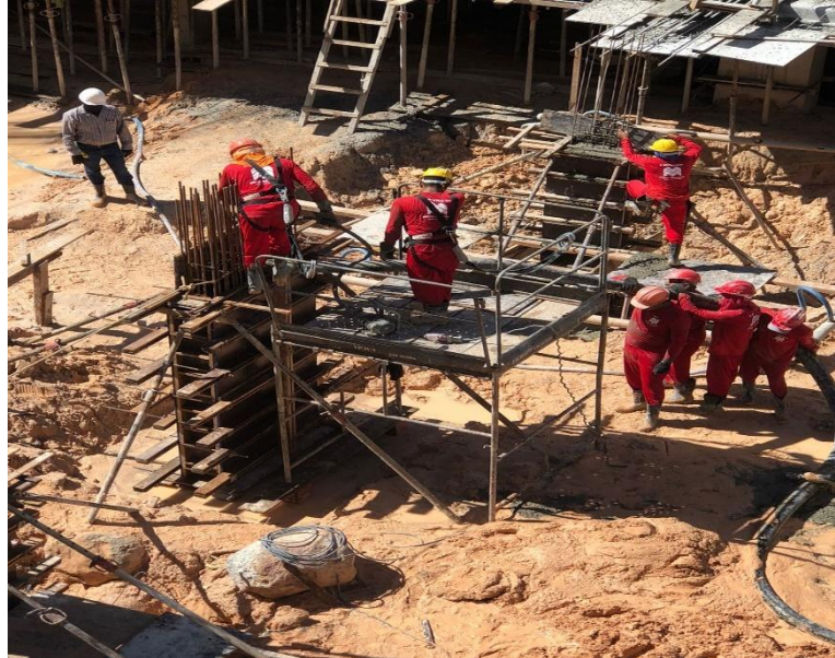
Figura 16 - Execução infraestrutura condomínio The Pallace
