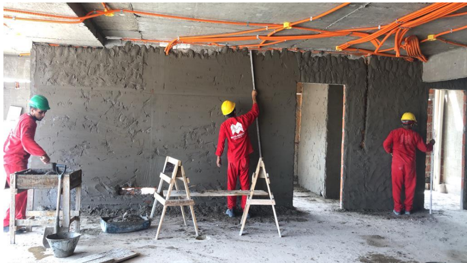
Figura 20 - Execução de atividade Reboco/Emboço
