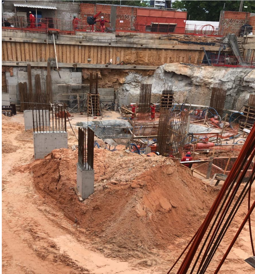
Figura 21 - Utilização de ponteiros e bermas para execução da infraestrutura
