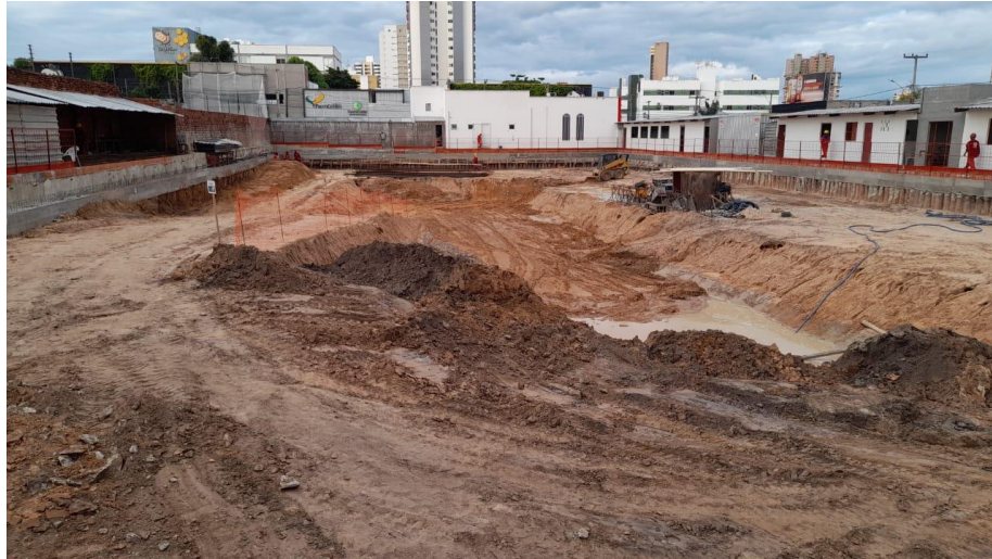
Figura 14 - Fase inicial da construção do condomínio The Pallace
