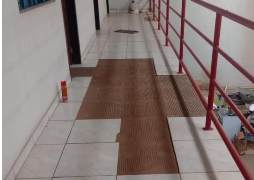
Figura 12 - Desplacamento cerâmico
