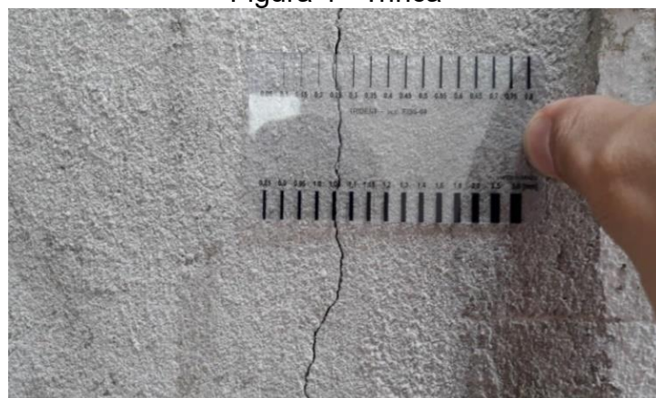
Figura 4 - Trinca
