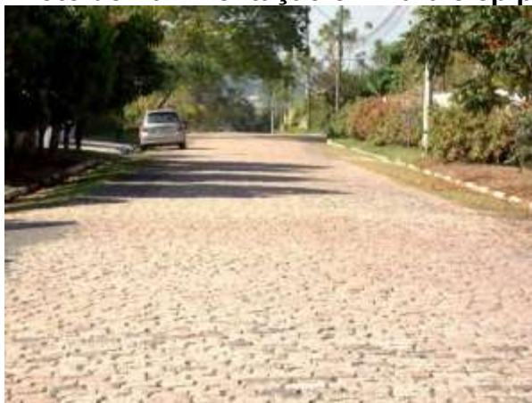
Figura 3 – Foto de Pavimentação em Paralelepípedo
