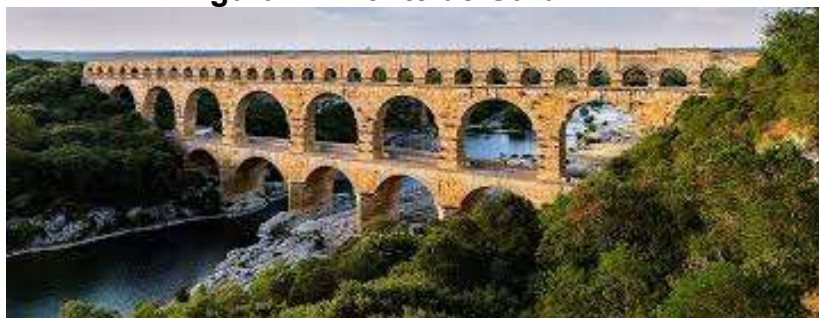
Figura 2 – Ponte de Gard
