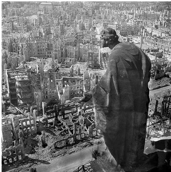
Figura 1- Fotografia da torre da Prefeitura, Dresden-DE
