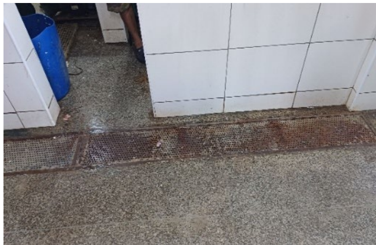
Figura 5: Áreas de drenagem do mercado central e esgoto ao ar livre
