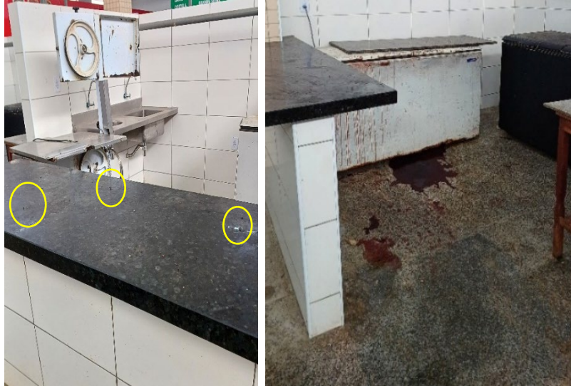
Figura 4: Balcão, piso e freezers mal higienizados.
