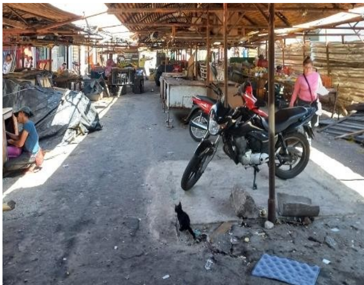
Figura 9: Situação de abandono e presença de animais.
