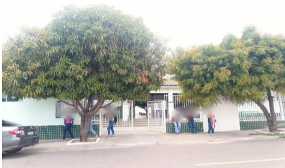
Figura 8 - Fachada da escola, CETI – Edith Nobre de Castro, onde o projeto foi aplicado
