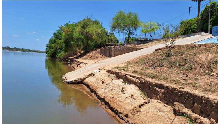
Figura 11 - Compactação do solo na margem do rio Parnaíba, localizado no ponto do The Pier flutuante.
