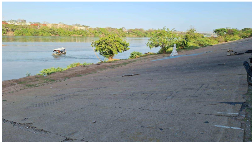
Figura 18 - Impermeabilização do solo da margem do rio Parnaíba, localizado no Troca-Troca.
