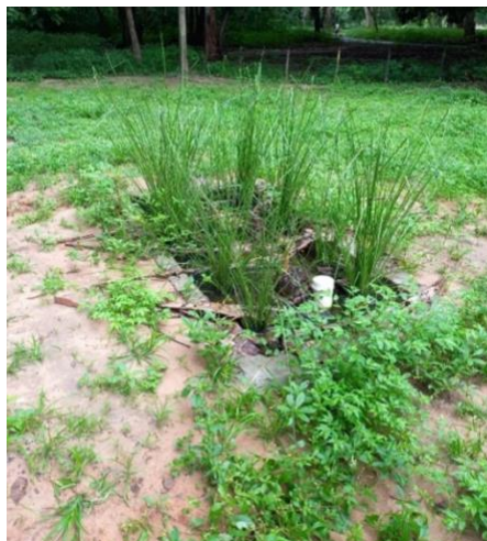
Figura 8 – Tanque de evapotranspiração
