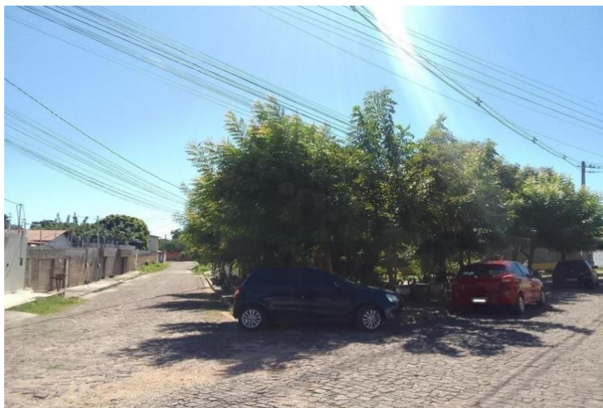
Figura 6 - Vegetação conflitando com a fiação elétrica na Praça do SAAE.
