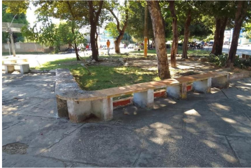
Figura 9 - Área sombreada do Canteiro da Avenida Paulo Ramos.
