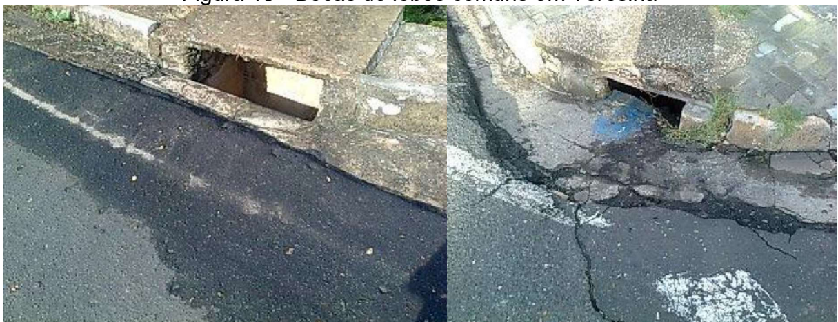
Figura 15 - Bocas de lobos comuns em Teresina
