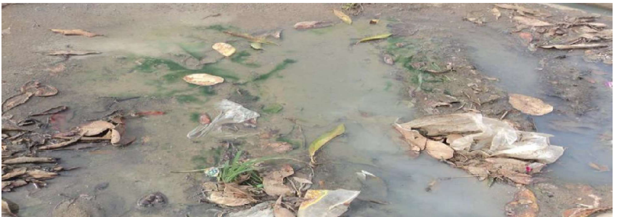
Figura 18 - Resíduos sólidos sobre sarjeta obstruída
