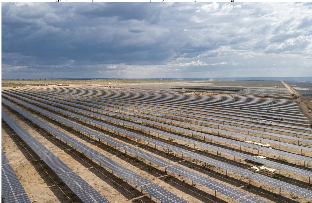
Figura 4: Parque Solar São Gonçalo, São Gonçalo do Gurguéia - PI
