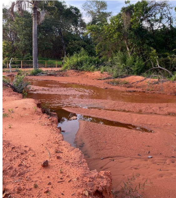
Figura 3 - Brejo do Buritizinho após o rompimento das bacias de contenção
