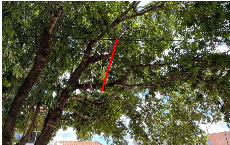
Figura 3: Evidências de fiação elétrica pelas árvores
