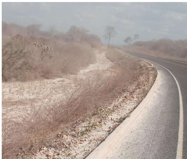
Figura 5: Trecho da PI-256
