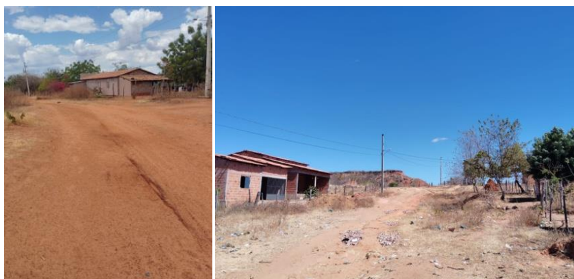
Foto 4 – Falta de pavimentação nas ruas do conjunto
