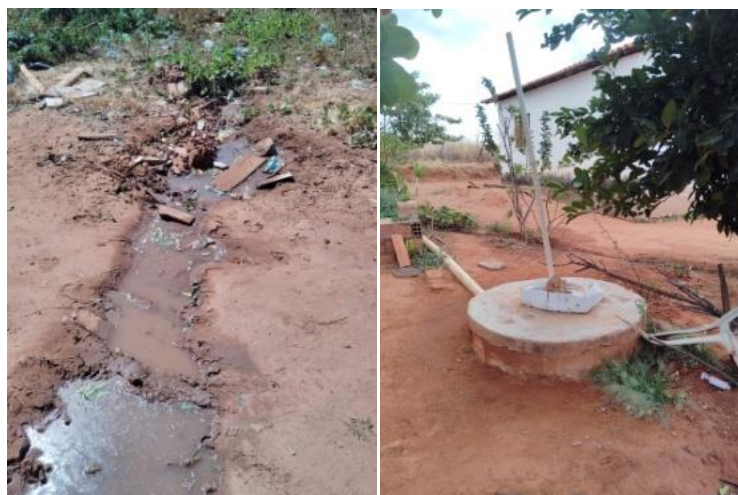
Foto 2 – Esgoto nas ruas e dispostos em fossa rudimentar
