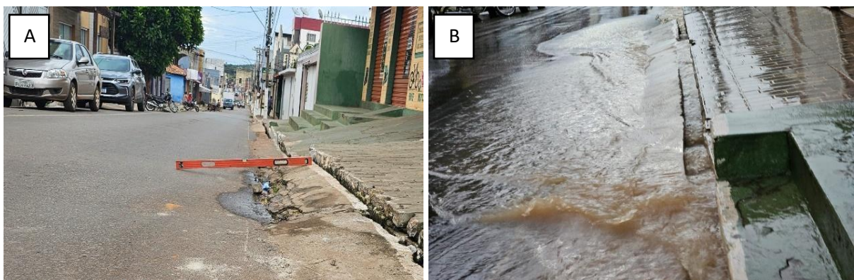
Fotografia 3 – Rampas de acesso no local da sarjeta
