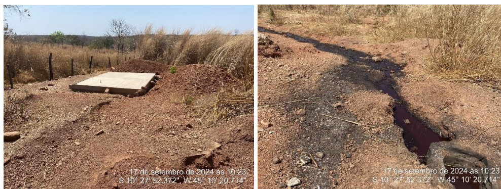
Figura 2 – Estrutura inadequada para alocação de efluentes
