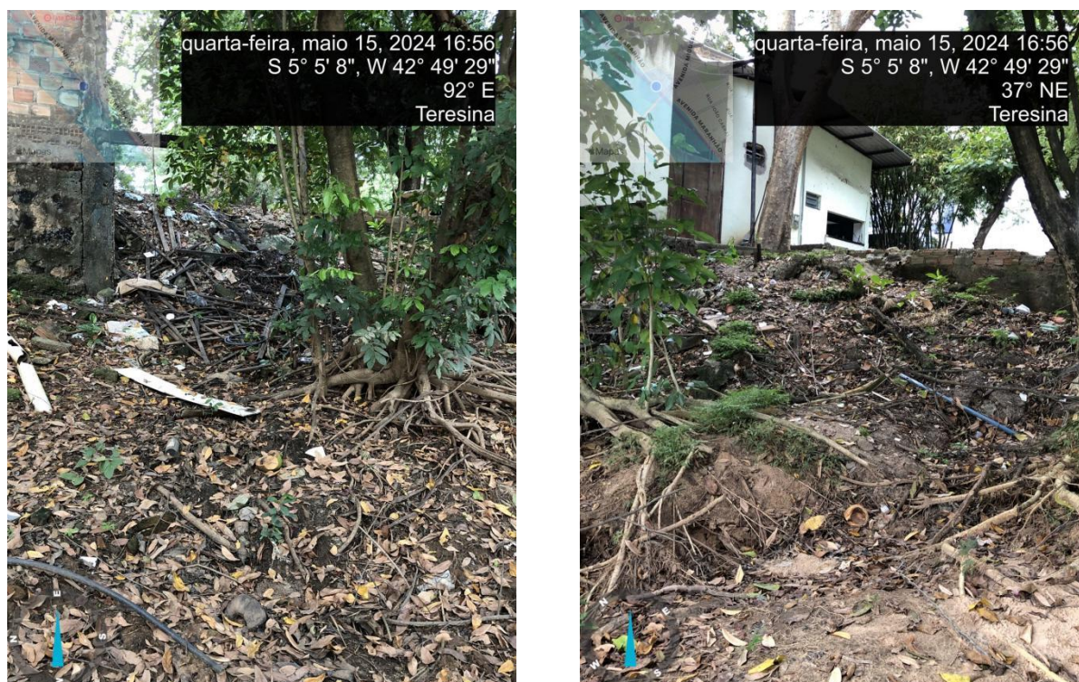
Figura 31 - Presença de Resíduos Sólidos.
