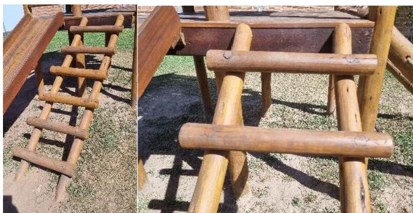
Figura 10 - Detalhes da escada
