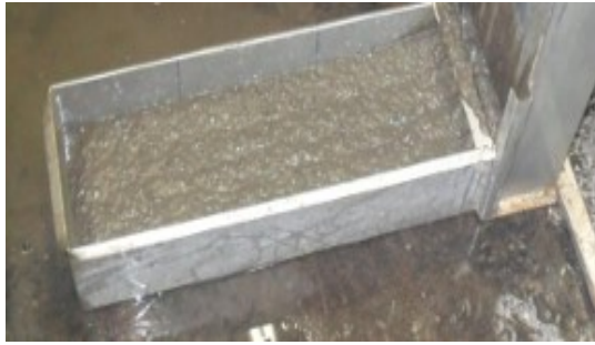
Figura 33 – Escoamento e nivelamento total do concreto.
