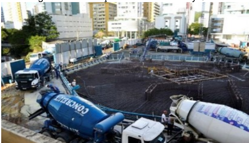
Figura 7 – Fundação do Edifício Infinity Coast.
