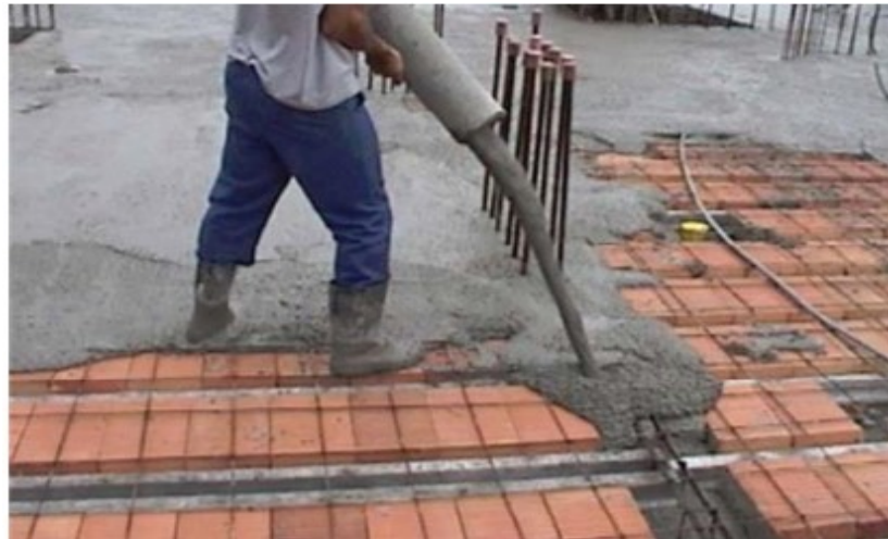
Figura 3 – Aplicação do concreto autoadensável.
