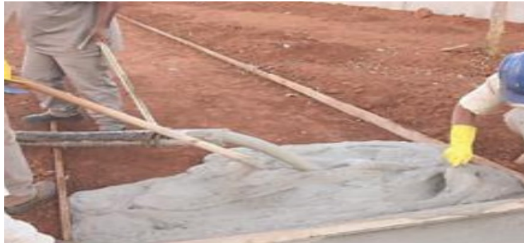
Figura 4 – Lançamento de concreto autoadensável.
